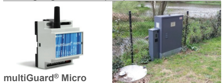
Overvågning af niveau i pumpebrønde
