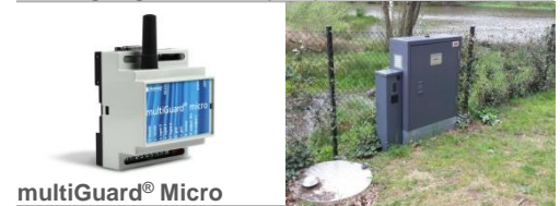
Overvågning af niveau i pumpebrønde
