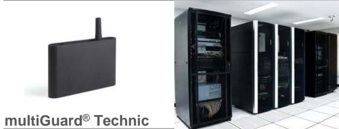
Overvågning af temperatur og strøm i serverrum
