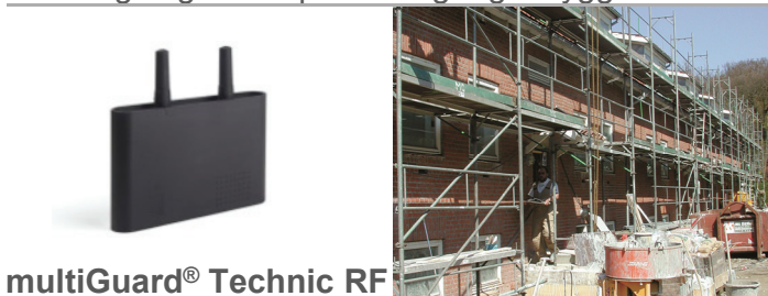
Overvågning af temperatur og fugt i byggeri
