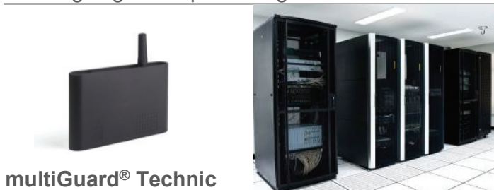
Overvågning af temperatur og strøm i serverrum
