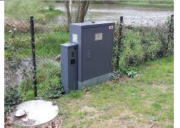
Overvågning af niveau i pumpebrønde
