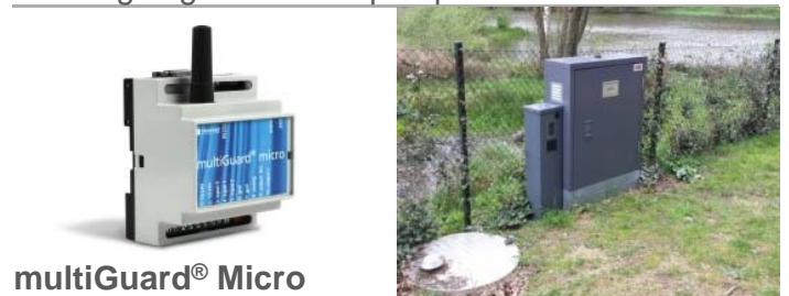
Overvågning af niveau i pumpebrønde
