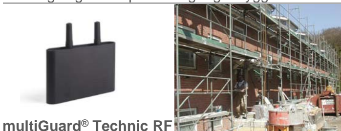
Overvågning af temperatur og fugt i byggeri
