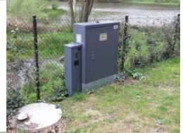
Overvågning af niveau i pumpebrønde
