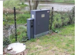
Overvågning af niveau i pumpebrønde
