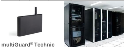
Overvågning af temperatur og strøm i serverrum
